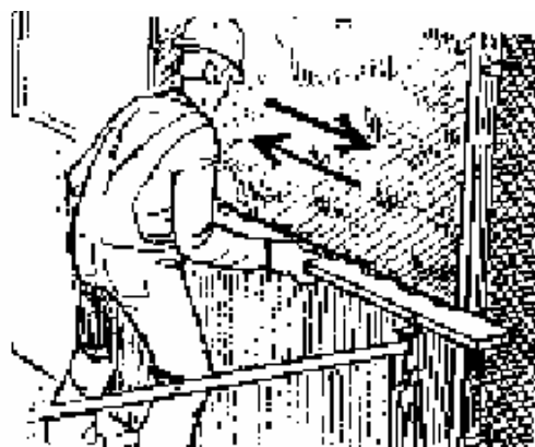
Rys.6. Wyrównanie warstwy narzutu po listwach tynkarskich [6]
