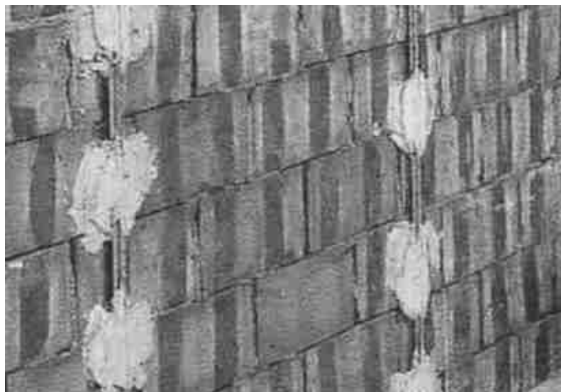
Rys.2. Wyznaczenie lica powierzchni tynku za pomocą listew aluminiowych [7]
